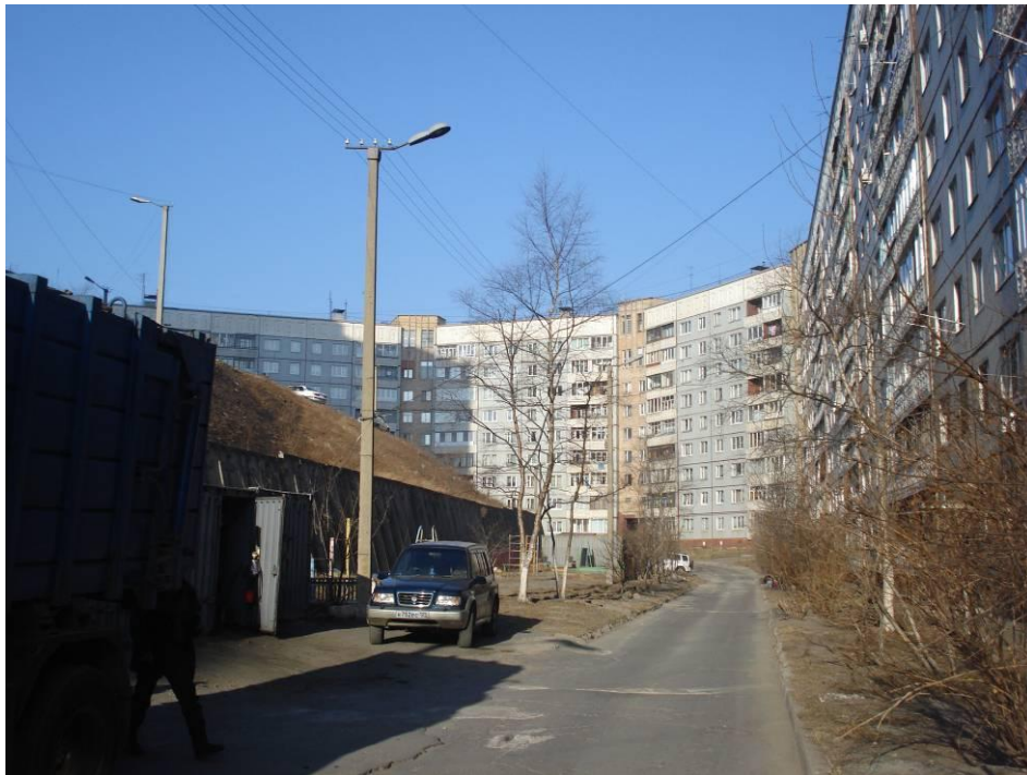
На снимке зафиксирован общий план обследуемого жилого дома
