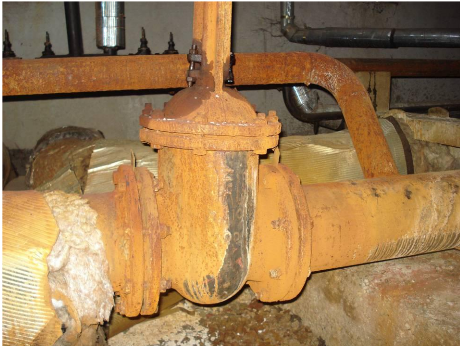
На снимке зафиксировано техническое состояние трубопроводов в подвальном помещении
