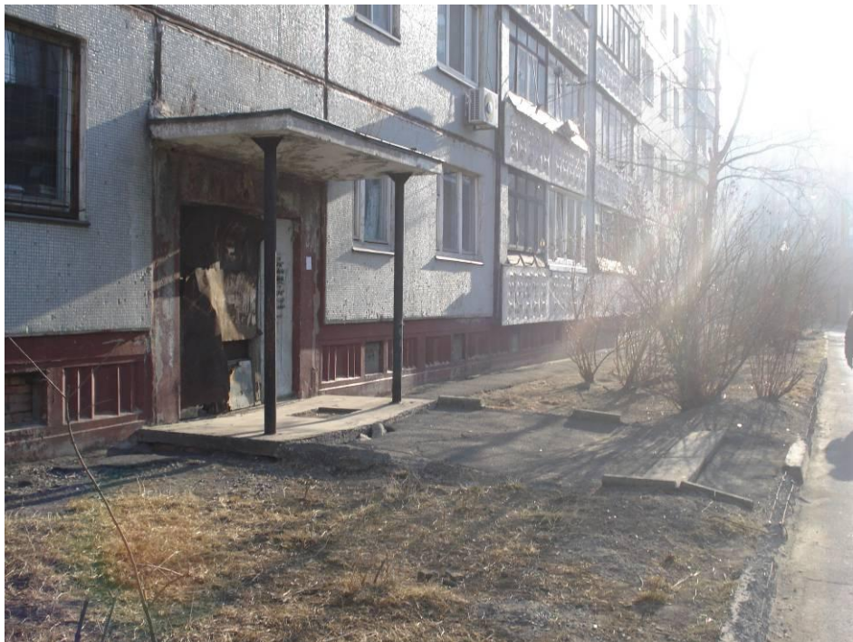
На снимке зафиксировано техническое состояние придомовой территории
